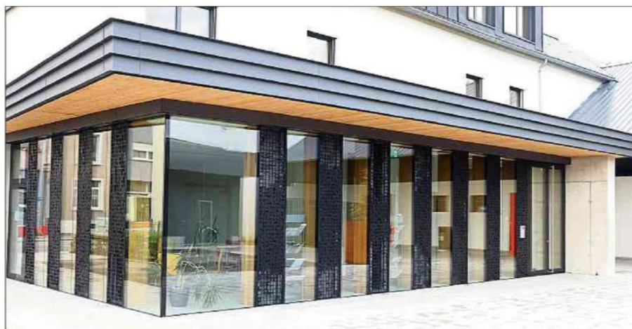
Der Hinterhof begeistert mit einer großen Fensterfront, die jede Menge Licht in den Versammlungsraum fallen lässt.
